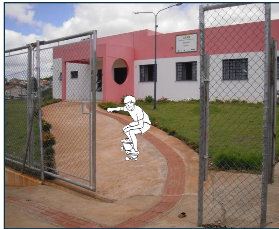
Falta rampa com inclinação adequada, corrimão
